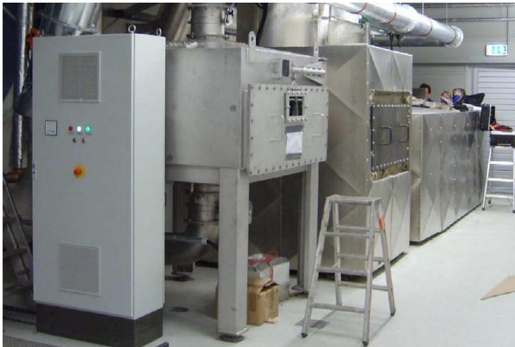
Molekularsiebgestützte NT-Plasmaanlage für 10.000 m<sup>3</sup>/h Abluft aus Herstellungsprozessen von Aromastoffen
